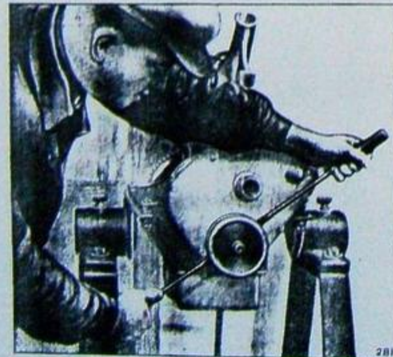
Fig. 18. — Enlèvement de la poulie du ventilateur.
