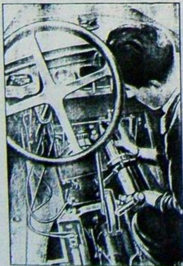
Fig. 2. — Dégagement de la plaque porte-pédales avec le démarreur.
