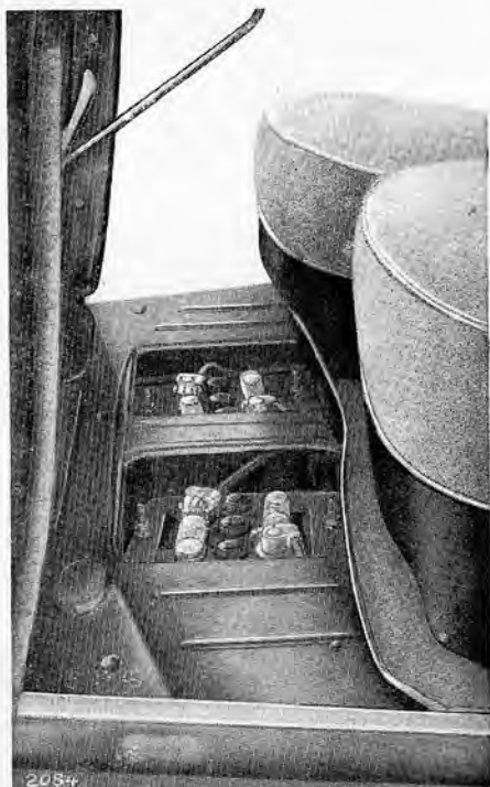
Fig. 28. — Vue montrant la facilité d'accès aux accumulateurs. On aperçoit sur le plancher les 3 bouchons démontés pour vérifier le niveau de l'électrolyte.
